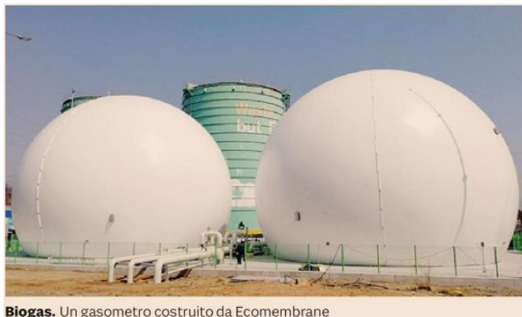
Biogas. Un gasometro costruito da Ecomembrane
